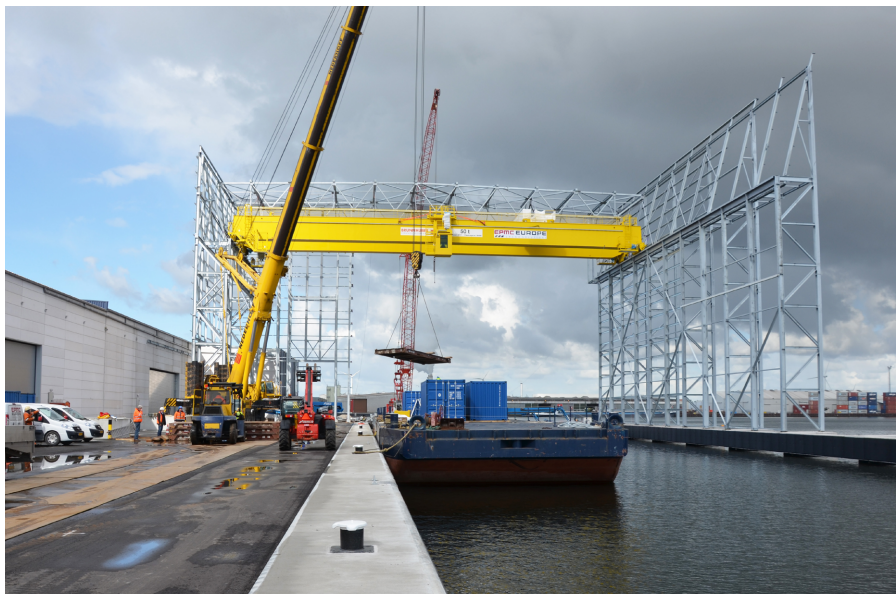
Die Kranbrücke wird in Amsterdam eingebaut
